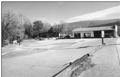
Avant : espace industriel à l'abandon.
