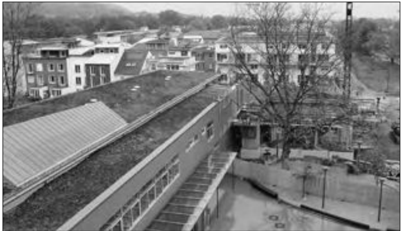
Panneaux photovoltaïques sur le toit vert d'une nouvelle école.
