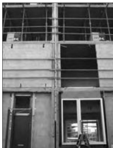
Un espace d'air entre les murs de béton qui séparent ces logements vise à augmenter l'insonorisation et la qualité de vie des futurs résidents.
