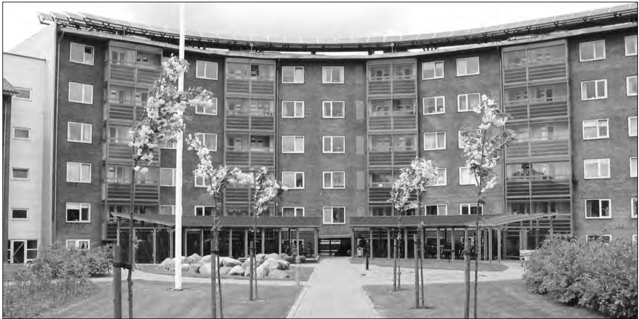
Panneaux photovoltaïques situés sur le toit et les balcons fermés du projet Solgården à Kolding (Danemark).
