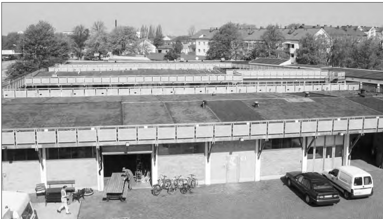
Toits verts sur les industries du quartier Augustenborg, à Malmö (Suède).
