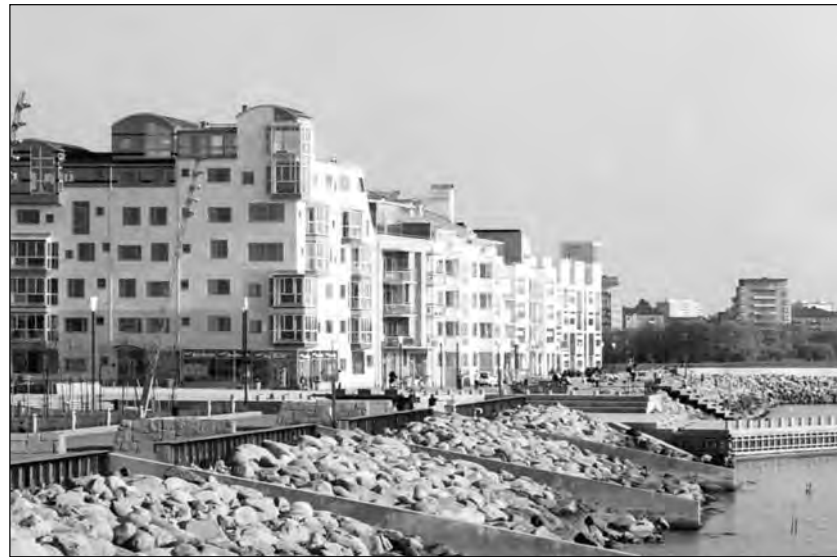
Front de mer et collecteurs solaires à Bo01, Malmö (Suède).
