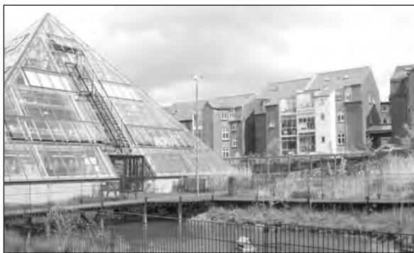
Unité de traitement biologique des eaux usées, de forme pyramidale.
