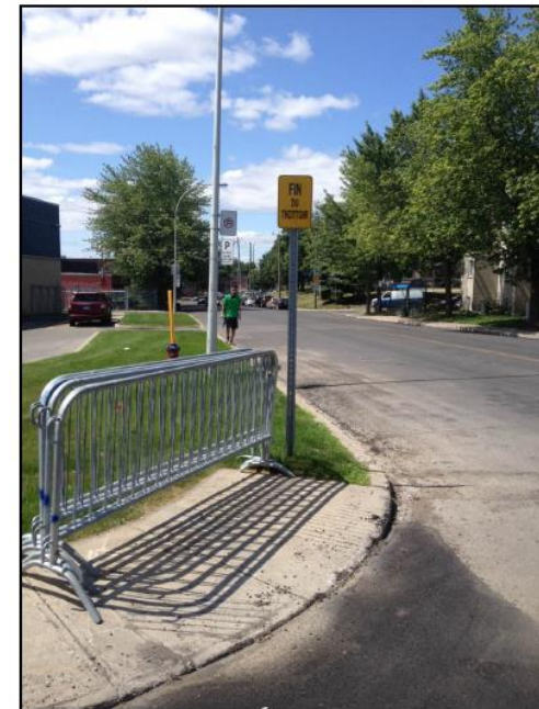
Figure 9 : Un exemple de la discontinuité de certains trottoirs, sur de Castille
