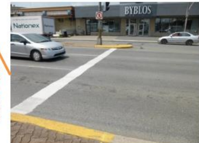
Figure 11 : La traverse à l'ouest de l'intersection des boulevards Côte-Vertu et Lebeau ne permet pas, elle non plus, aux piétons de traverser. Elle est à proximité de centre d'achat où se trouvent entre autres une épicerie et plusieurs commerces de proximité.
