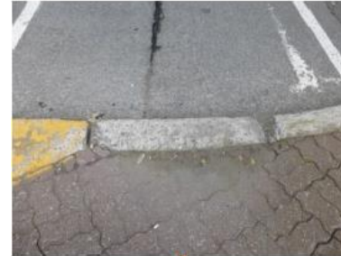
Figure 9 : Comme ce bateau pavé se trouvant à l'intersection des boulevards Côte-Vertu et Jules Poitras, plusieurs bateaux pavés présentait des problèmes au niveau de l'accessibilité.
