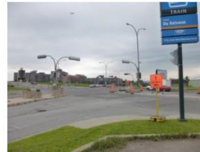
Figure 6 : La configuration de l'intersection des boulevards Henri-Bourassa et Jules Poitras n'est pas adéquate pour les piétons. On dénote entre autres des problématiques au niveau du bateau pavé sur la traverse nord, une interdiction de passer sur la traverse est, peu de temps pour la traverse piéton au coin sud-est de l'intersection, des lignes d'arrêt et des priorités piétonnes non respectées.
