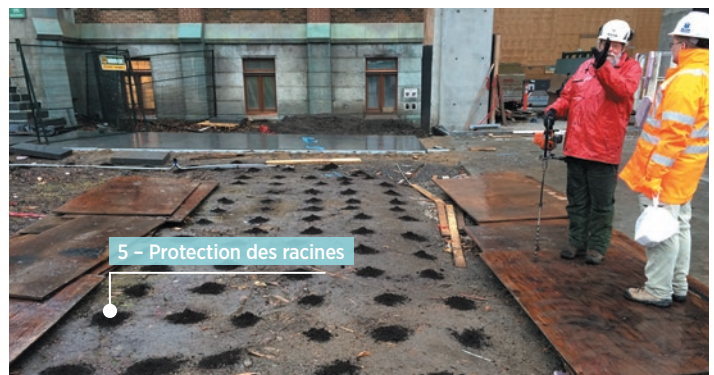
Chantier du Pavillon Lassonde, Québec | Source: Jean Lamontagne
