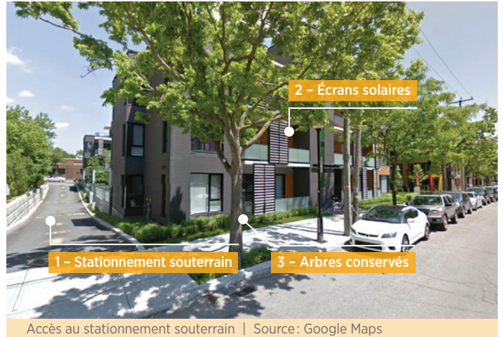
Accès au stationnement souterrain | Source: Google Maps
